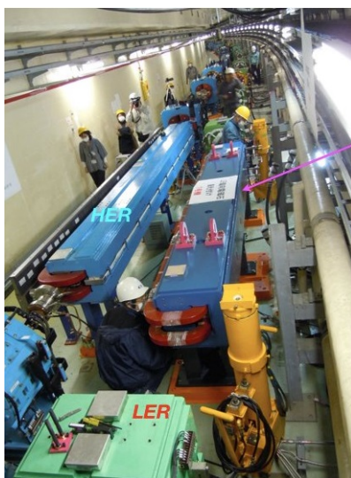
Slika 12. Nameščanje prvega glavnega dipolnega magneta nizkoenergijskega obroča na desni strani slike in že nameščeni dipolni magneti visokoenergijskega obroča na levi strani slike. Posamezni magneti so dolgi približno 4 m. Slika je bila posneta februarja 2012.
